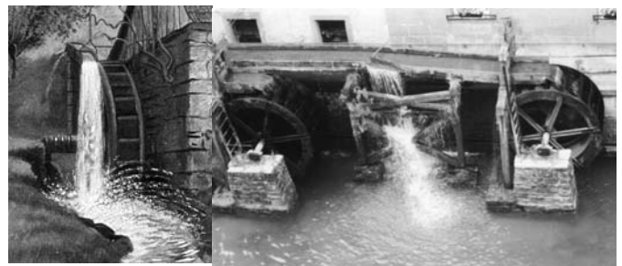
Oberschlächtinge Wasserräder mit verschiebbaren Känneln.
