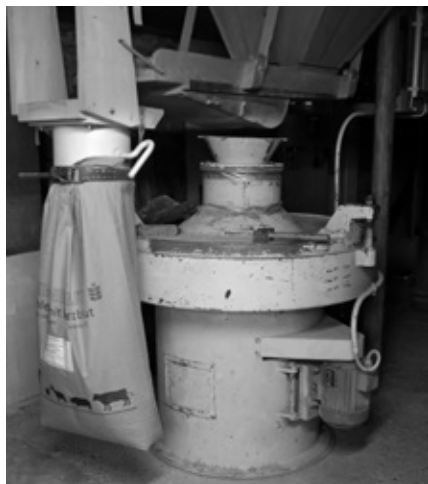
Horizontaler Röllgang Mühle Schwanden Anlage Nr 10
