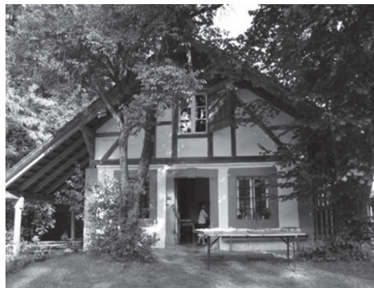
Ofenhaus Flüelenmühle (Anlage Nr. 21)
