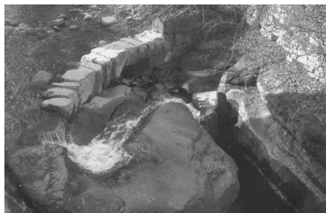
Abb. 2 La retenue d'eau et le captage (1699)
