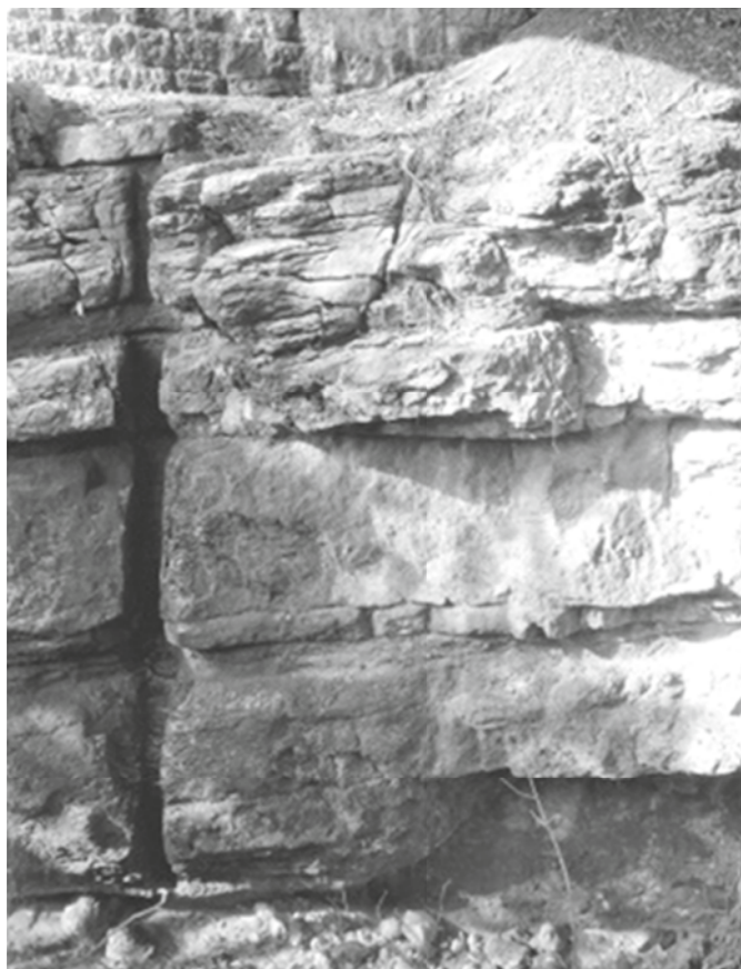
Abb. 3 Les encrages des râteaux (8 m de haut)
