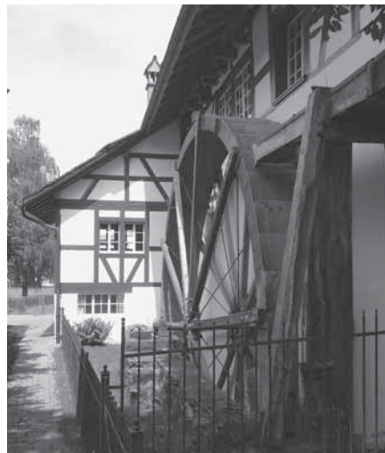
Wasserrad Geigenmühle Anlage Nr. 82
