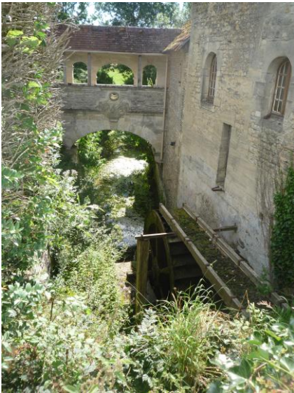
Abb. 8 Das oberschlächtige Mühlrad der Mühle von Foulon (2012)
