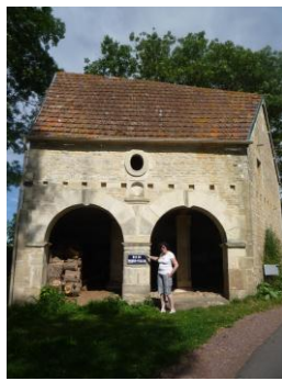
Abb. 9 Nebengebäude der Mühle von Foulon mit Schild „RUE DU MOULIN-FOULON“ (2012)
