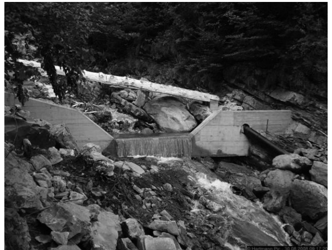
Abb. 4: Neue Wasserfassung im Guschnertobel (Foto Verein Pro Guscha)
