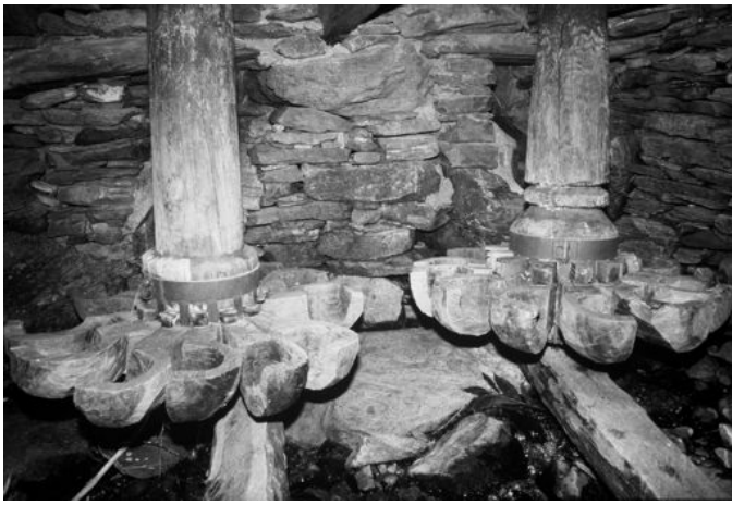
Abb. 2. Löffelräder der Mühle in Dandrio, Val Malvaglia, Tessin (Foto: Autor 1985).
