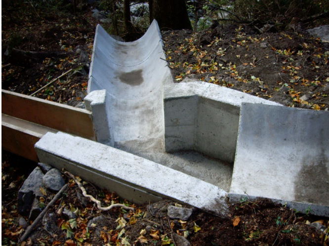
Abb. 3. Schieberschacht.
