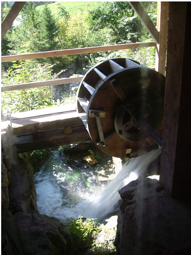
Abb. 7. Blick vom Kellerraum auf das Wasserrad.
