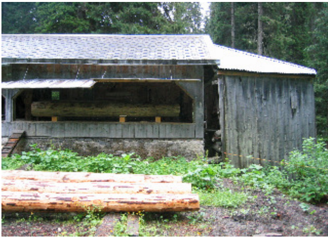
Abb. 5. Südlicher Teil der Säge mit dem später auf Geheiss der Brandversicherungsanstalt angebrachten Lawinkeil (rechts).
