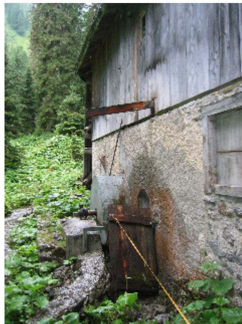
Abb. 4. Das unterschlächtig angetriebene eiserne Mühlrad an der Ostseite ist mit einer Blechummantelung geschützt. Darüber ein Überrest der Tragkonstruktion für die frühere Wasserzufuhr durch einen Holzkänel.
