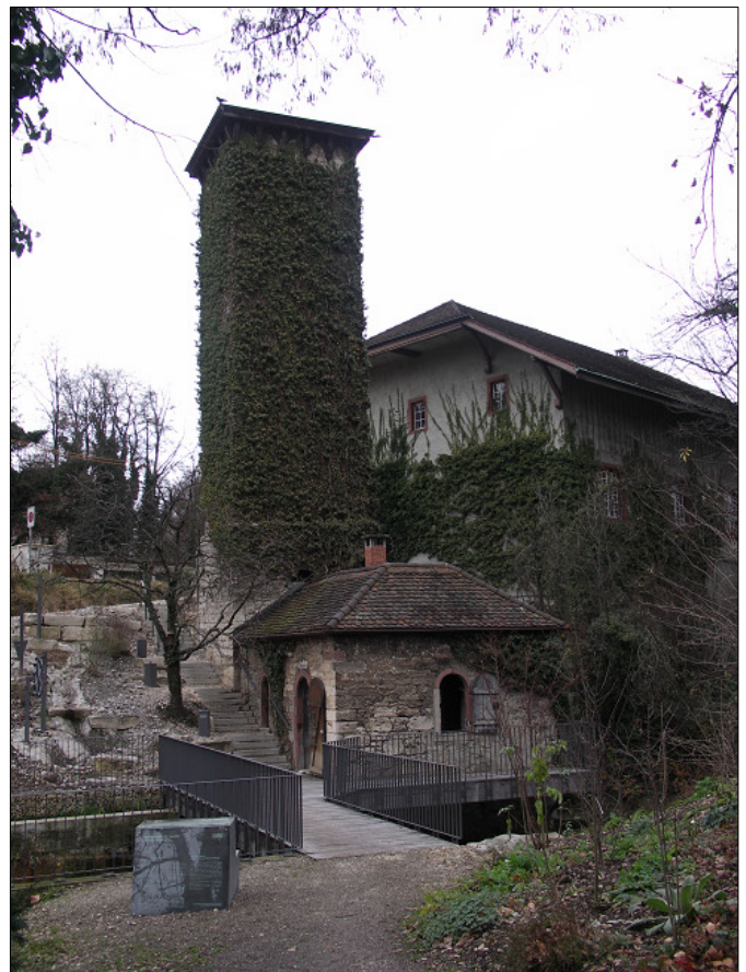
Abb. 8. Das 2006 restaurierte Brunnenwerk St. Jakob.
