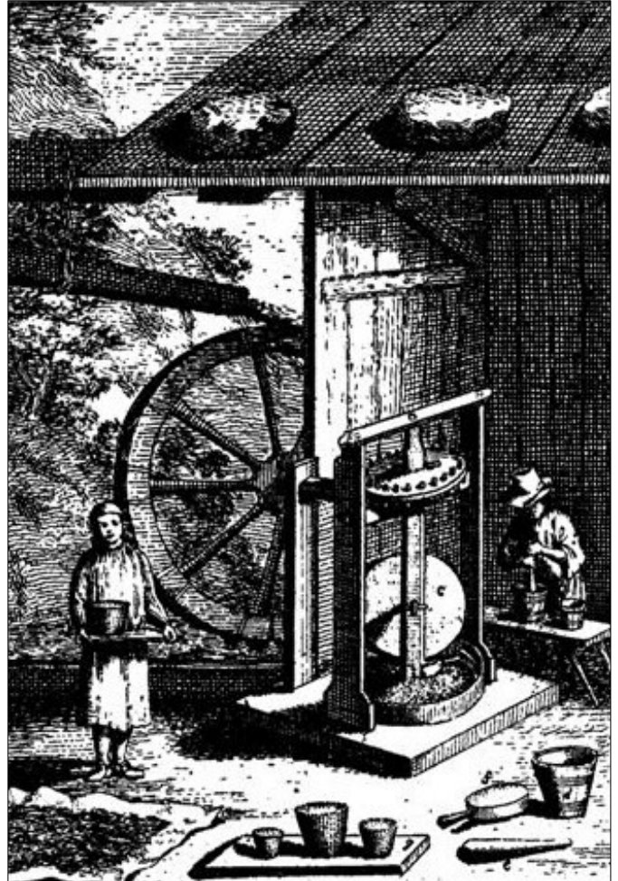
Abb. 1. Bei der Glarner Schabzigmühle handelt es sich um eine der vielen Einsatzmöglichkeiten des Kollergangs.
