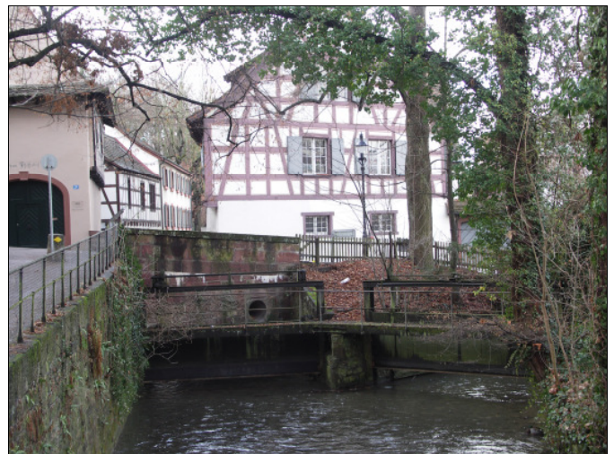
Abb. 4. Der Teiler des St. Alban-Teiches mit den beiden Schützen (links vorderer Teich, rechts hinterer Teich).
