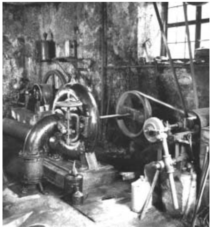
Abb. 20 Im Schmiederaum stand eine kleine Pelton-turbine. Diese wurde bei der Restauration ausgebaut. Gut sichtbar ist der Riemenantrieb für die Schleifscheibe. Der Generator ist leider nicht auszumachen. Quelle: Landesarchiv des Kantons Glarus
