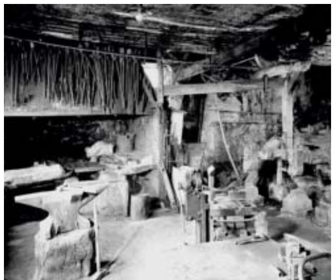
Abb. 21 Innenraum der Schmiede vor der Restauration. Quelle: Landesarchiv des Kantons Glarus
