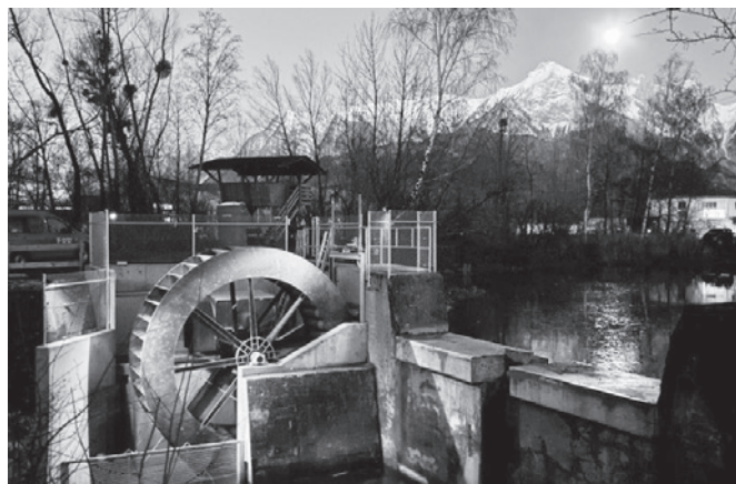
Nachtaufnahme des Wasserrads am Kiesfang des Vilterserbachs in Vilters
