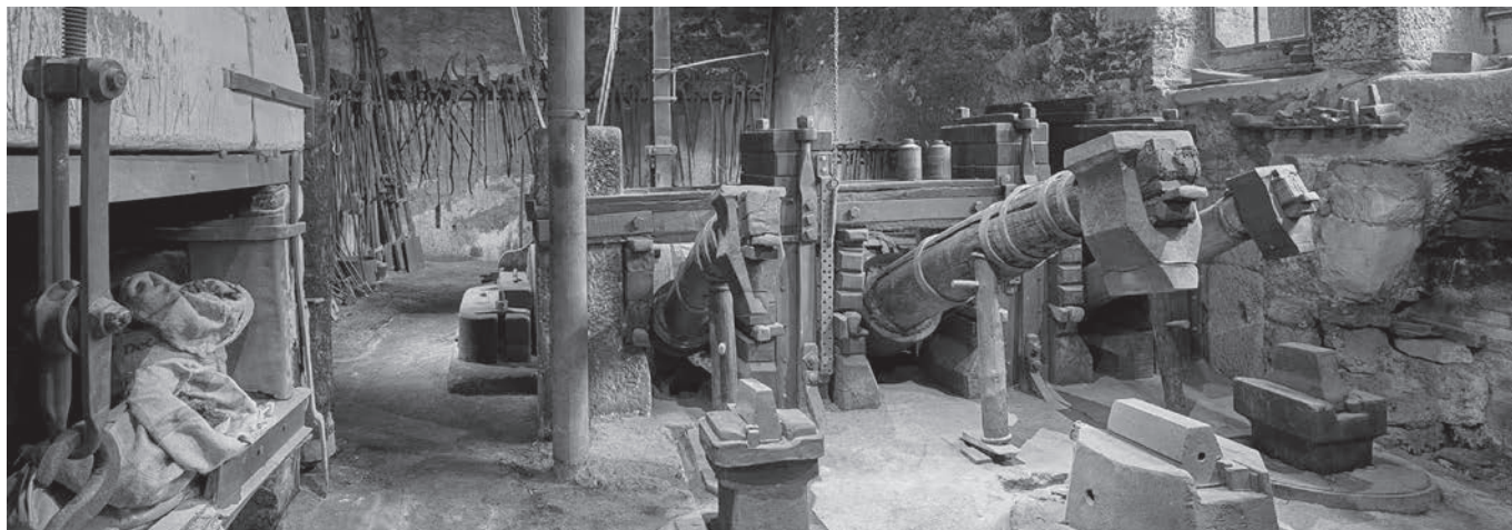
Hammeranlage mit sanierungsbedürftigem, eichenem Wellbaum und drei wassergetriebenen Schwanzhämmern aus dem 19. Jahrhundert.
